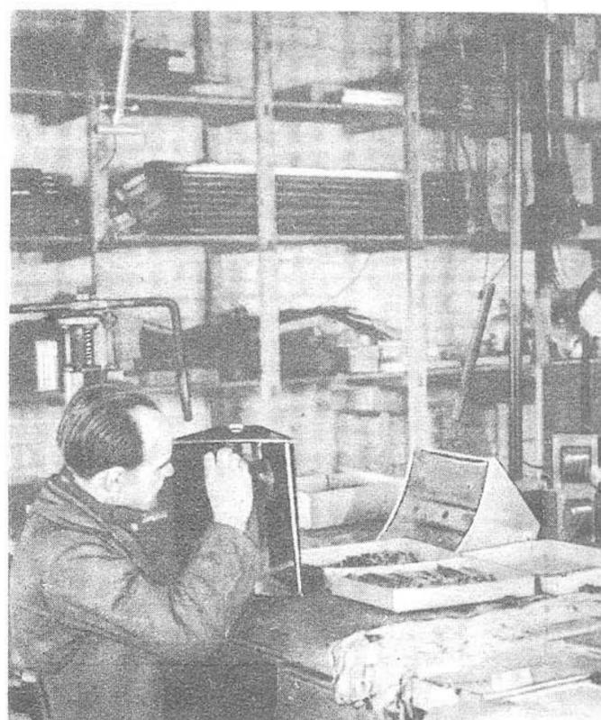
Einbau der Einzelteile in das Reflektorgehäuse
